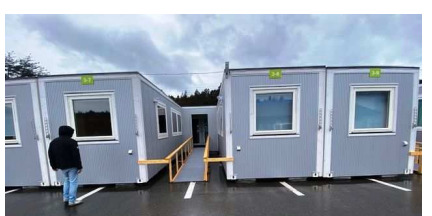
開設したばかりの仮設住宅。見た目はコンテナようですが、中は北海道仕様で、木材の内壁で、木の匂いのする仮設でした
