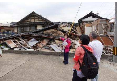
倒壊家屋が多い能登島・野崎の地域
